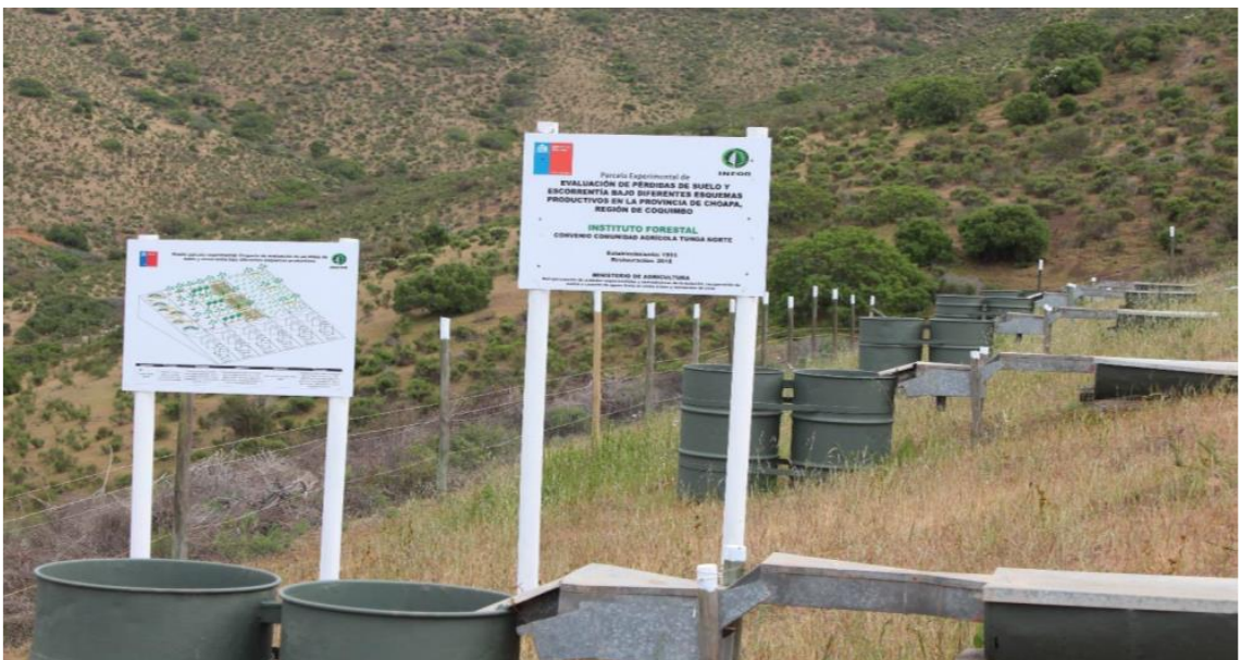
PLANTACIÓN Y REHABILITACIÓN DE LAS ESTRUCTURAS DE LA UNIDAD QUEBRADA DE QUELÓN TUNGA NORTE COMUNA DE ILLAPEL
