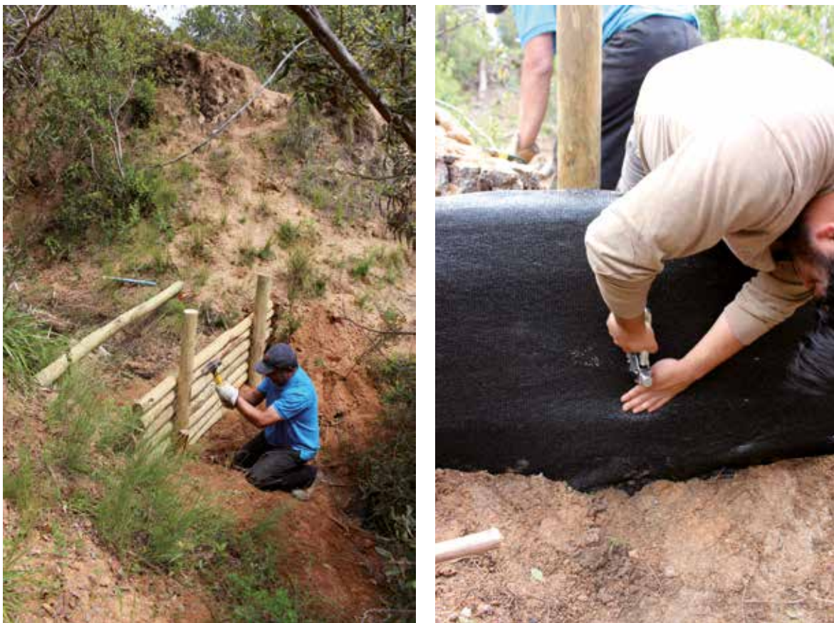
Figura 24. Construcción de diques de contención para control de erosión en cárcavas.
