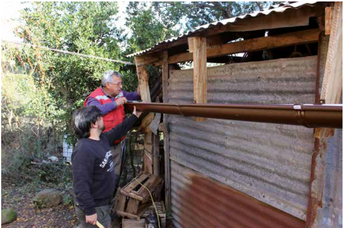
Figura 22. Instalación de canaletas para colecta y canalización de aguas lluvia.
