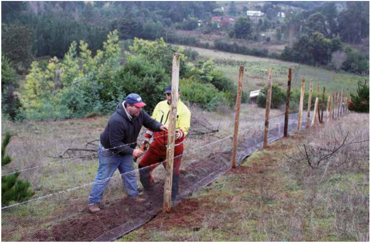
Figura 17. Construcción de cerco.
